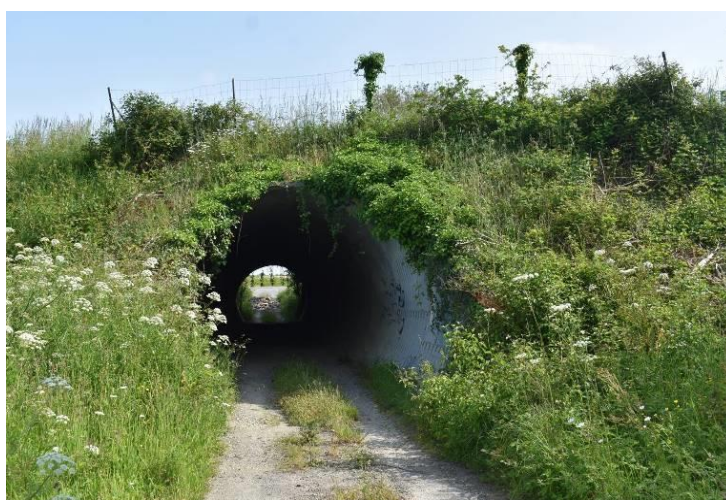
Tunnel présent au-dessous de la RD537, à proximité de l'emprise du projet [Socotec – mai 2023]
