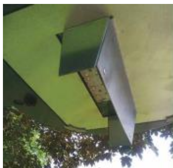
Exemple de lampadaire comportant plusieurs modules LED de températures de couleurs différentes munis de coupe-flux [Yohann Tisson – Ville de Lille]
