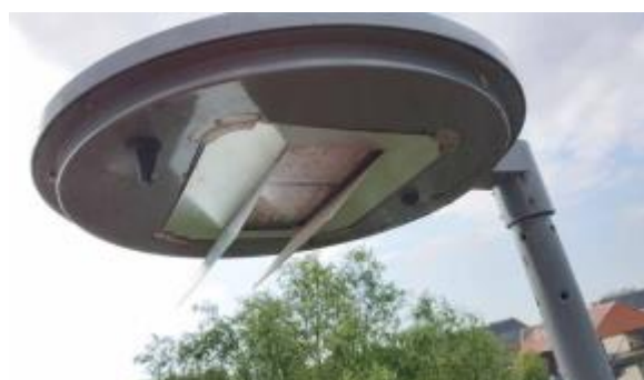
Exemple de lampadaire comportant plusieurs modules LED de températures de couleurs différentes munis de coupe-flux [Yohann Tisson – Ville de Lille]
